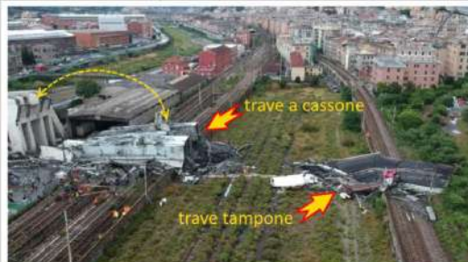
elementi crollati sui binari; a sinistra, la parte di trave a cassone finita sottosopra; a destra, la trave tampone
