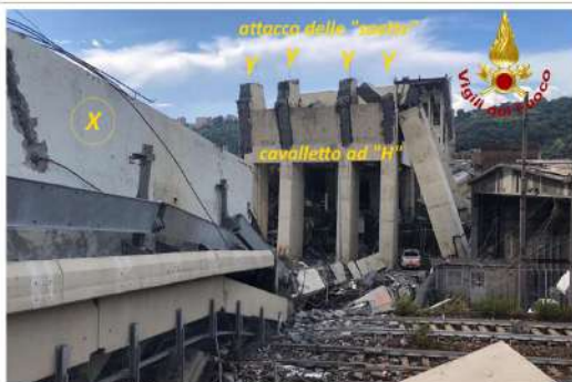
X: tratto B'E' ruotato di 180°; Y: punti di rottura "saette"
