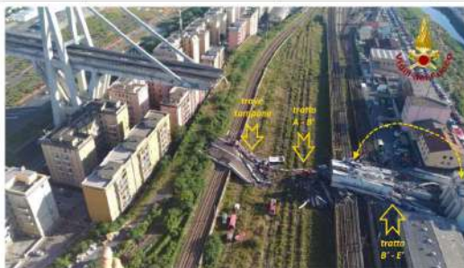
traslazione tratto A'-B' e rotazione di 180° del tratto B'-E'
