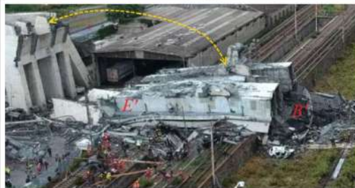
particolari della parte di trave a cassone finita sottosopra: ossia ruotata di 180° attorno all'asse trasversale del viadotto.
