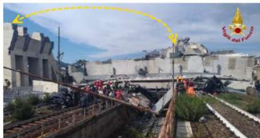
particolari della parte di trave a cassone finita sottosopra: ossia ruotata di 180° attorno all'asse trasversale del viadotto.
