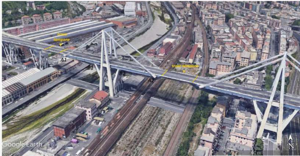
vista da sud della pila nove sul Viadotto Polcevera, crollata il 14 agosto 2018
